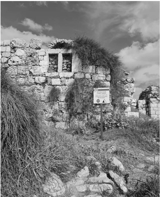
Paisaje de Palestina con un cartel que dice “Peligro de colapso ¡no pasar!”. Cortesía de Rawan Nemer.
